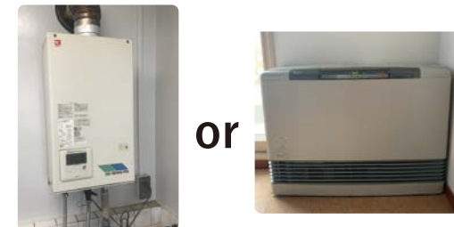
給湯器 OR FF暖房 (排気筒等にて屋外に排気しているタイプ) (壁に固定しているタイプ)
